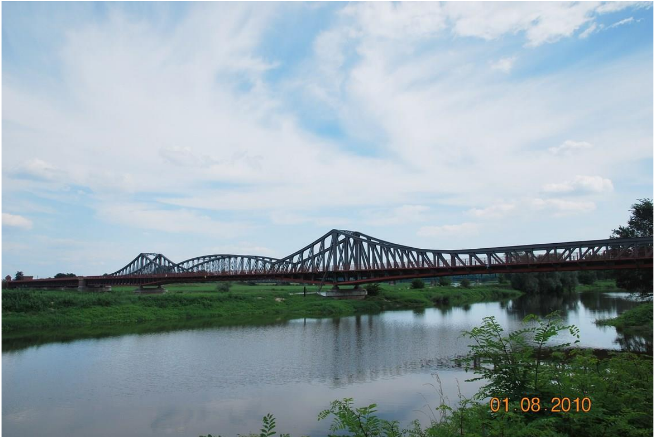
Ścinawa – 2010 r. Most drogowy na Odrze, widok od strony północnej. Na pierwszym planie widoczne wejście do basenu portowego, za wałem główny nurt rz. Odry. Fot. Andrzej Powidzki
