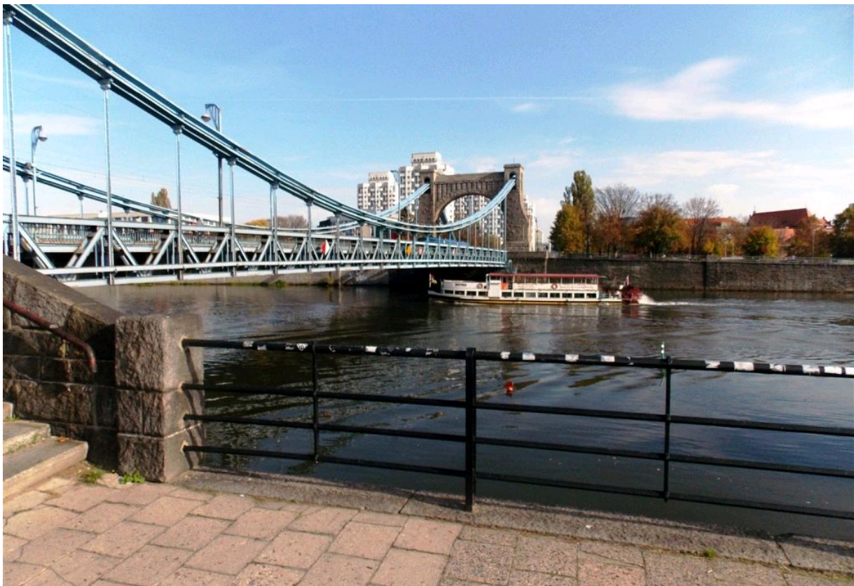
Wrocław, Most Grunwaldzki, 30.10.2022. (fot. Andrzej Nawrot)
